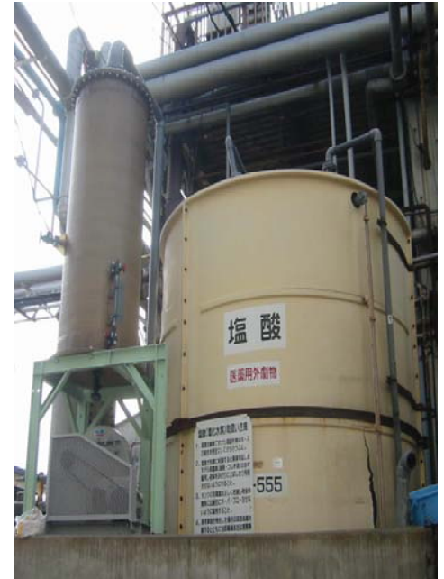
塩酸タンクとHCL-fog除去装置
