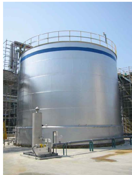
発煙硫酸タンクと白煙（硫酸ミスト）除去装置
